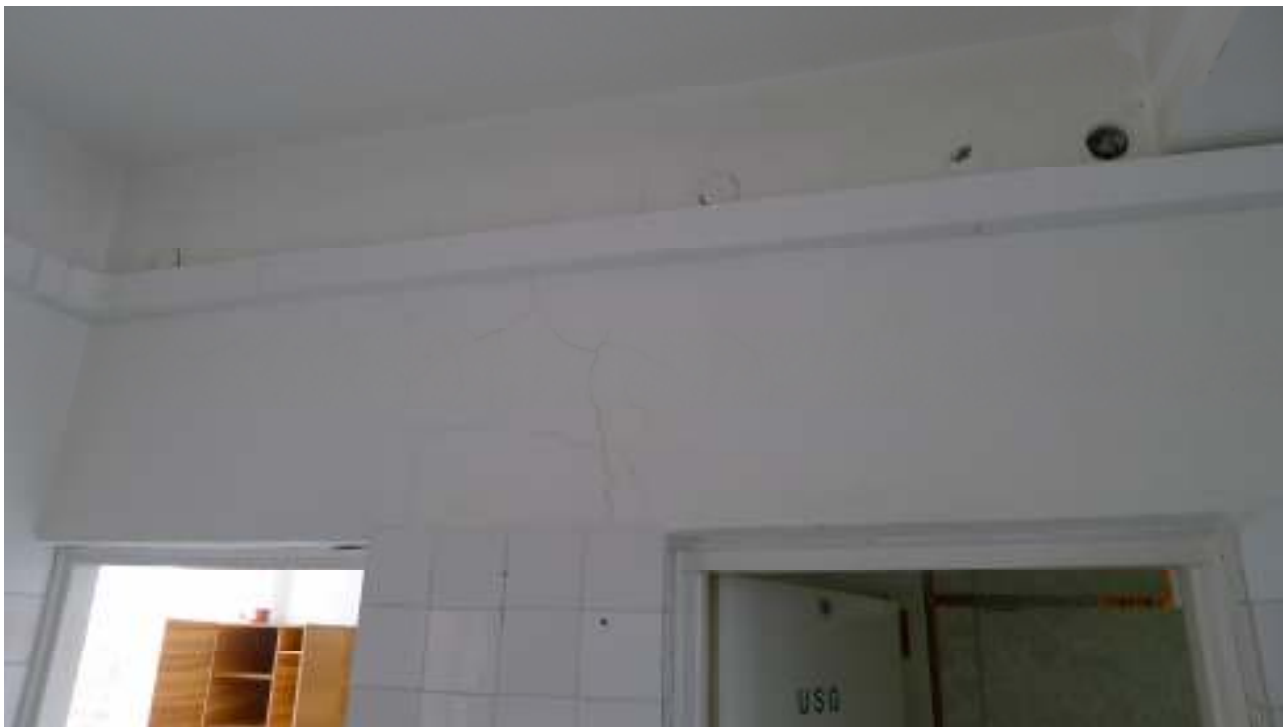
fot. 7 – Zarysowania powierzchni ścianek działowych
