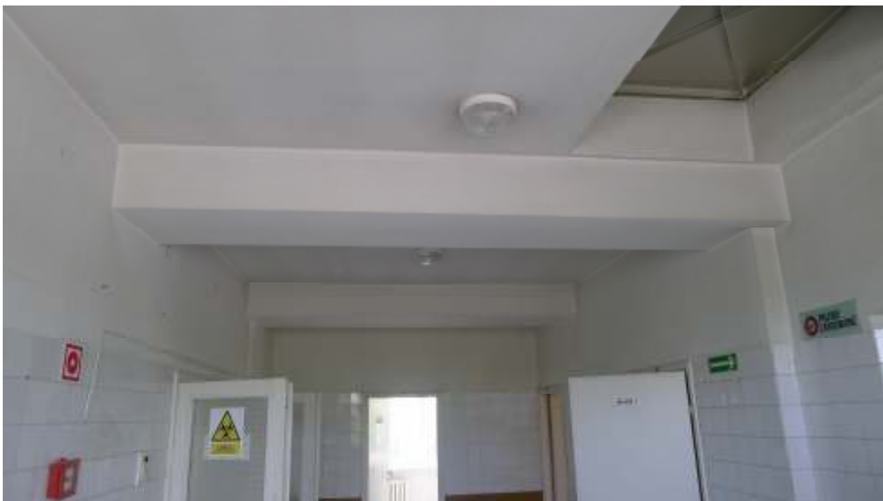
fot. 8 – Układ konstrukcyjny żebier wewnętrznych przy klatce schodowej
