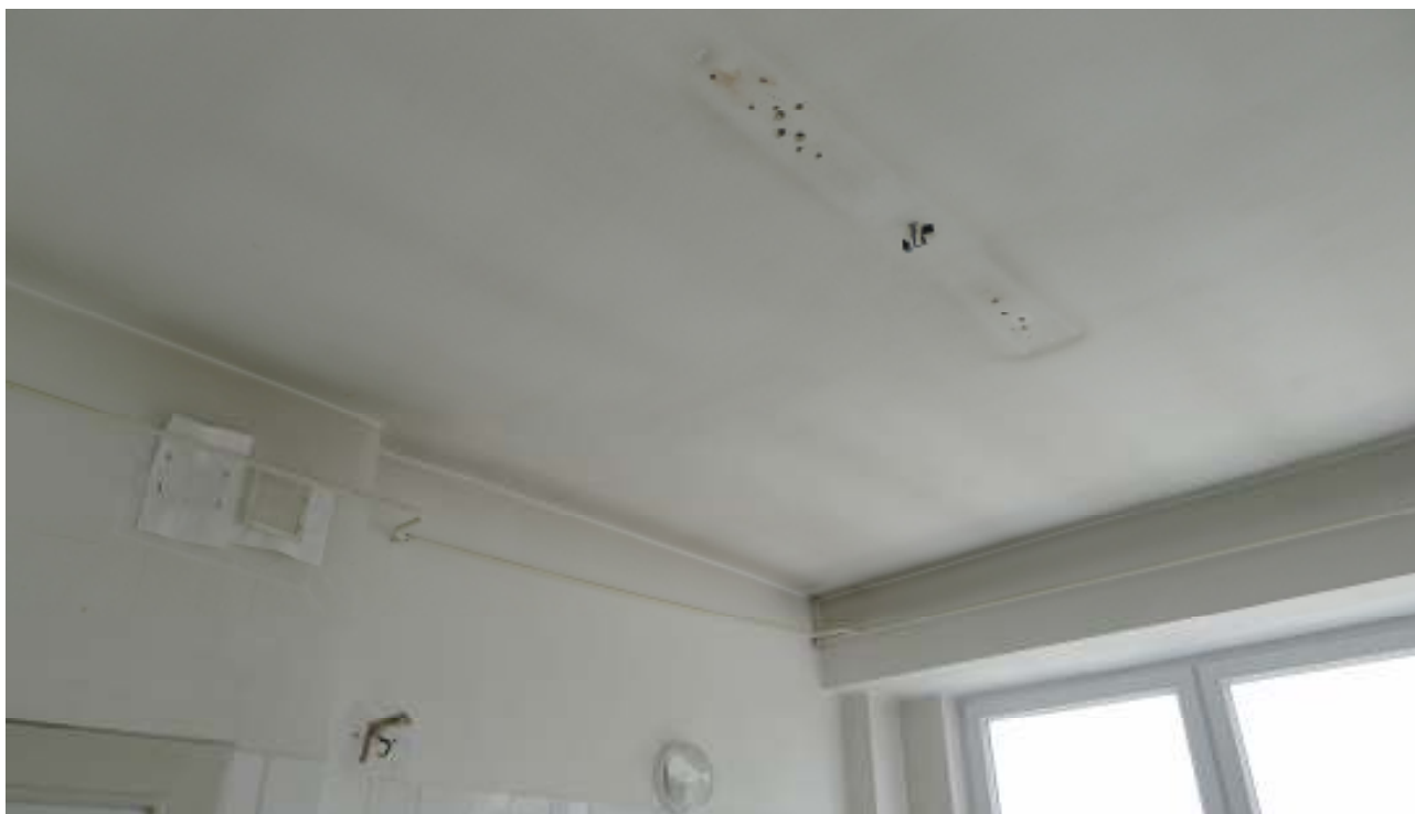
fot. 5 – Widok wnętrza – widoczne nadproże podłużne okien oraz zacielenia na żebrach stropu
