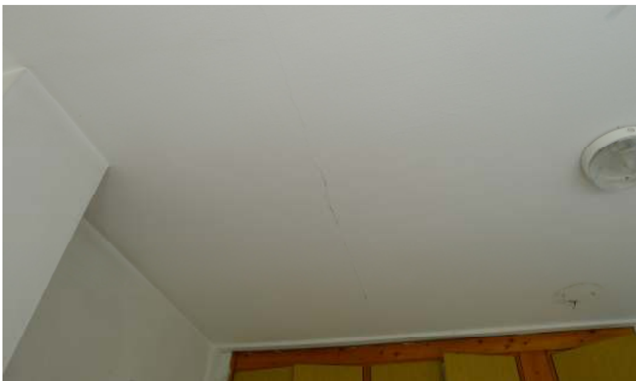
fot. 6 – Zarysowanie stropu w linii żeber
