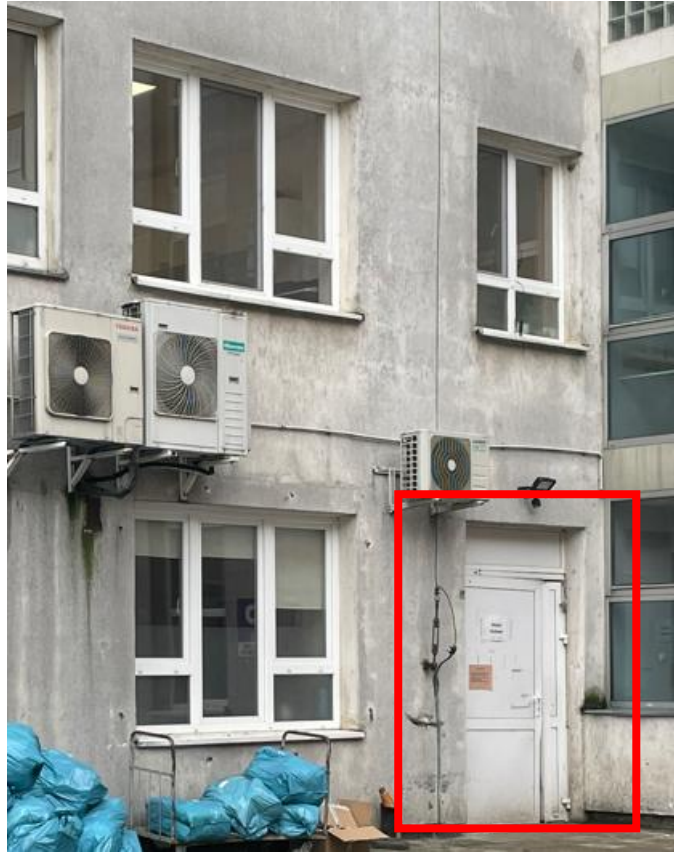
2. Drzwi do magazynów
